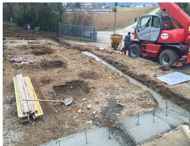
Les travaux continuent aux Brûlats pour les chalets du centre de loisirs
